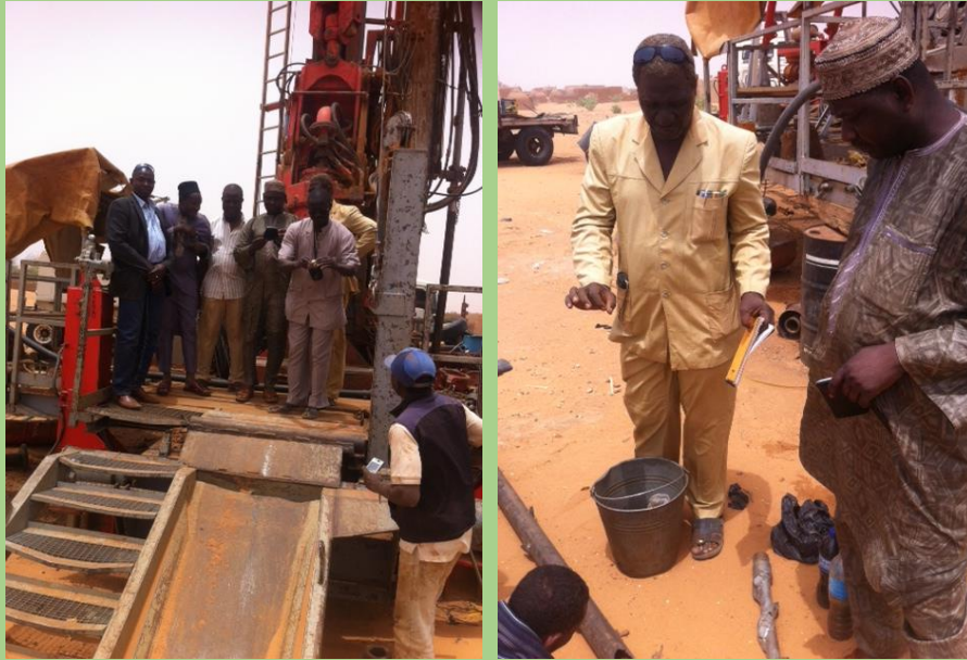
Samen op de foto bij de installatie
