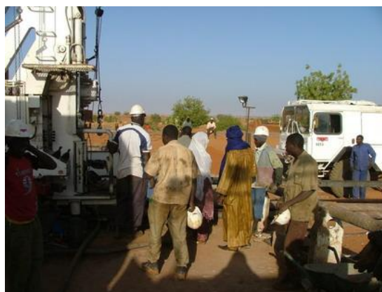
Travaux de forage à Afala
