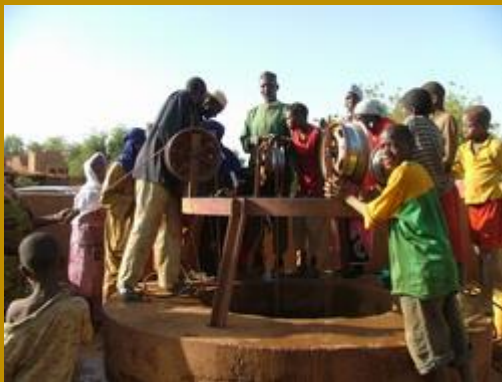
Een traditionele gecementeerde waterput
