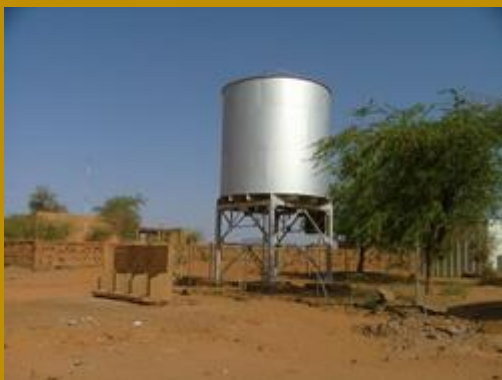
Op de voorgrond de kranen
